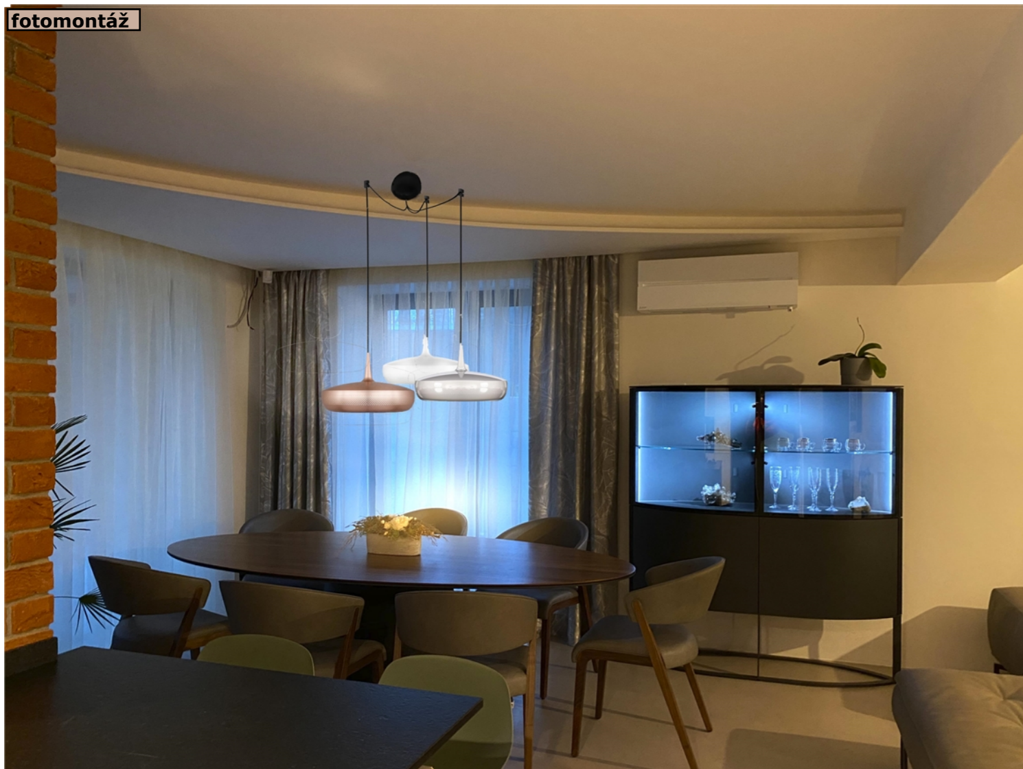
Pohled od vstupu na světla nad jídelním stolem
